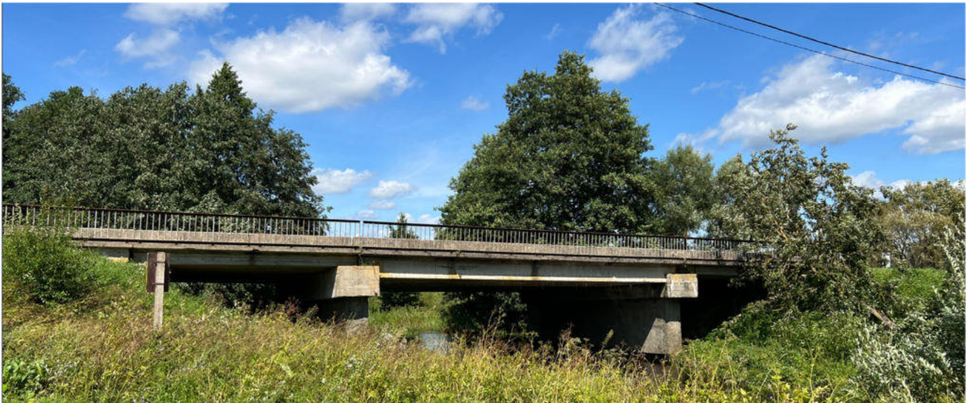
2 pav. Tilto per Merkio upę fasadinis vaizdas
